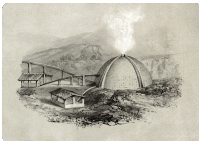
Figura 3.16: il "lagone coperto" di F. J. de Larderel in un'incisione da "Album des diverses localités formant les établissements industriels d'acide boracique fondés en Toscane (1818) par le Comte de Larderel".
